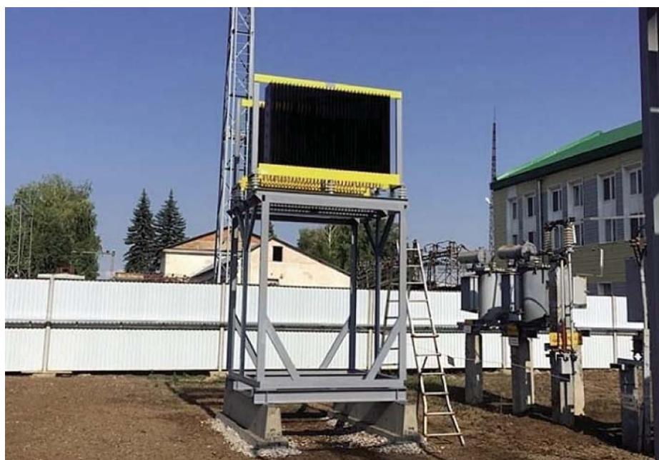
Рис. 3. Монтаж резисторов на ПС «Дёма»
