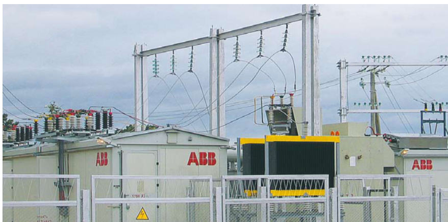
Рис. 2. Резистор РЗ-8000-51-35 в сети 35 кВ ПС «Хужир» (о. Ольхон, оз. Байкал)
