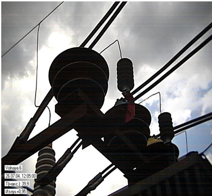
Фото 2. ОПНы типа Varisil HE15 на шинном мосту Т-2 ПС Вольная. ОПНы установлены на кронштейне с опорными изоляторами вместо вентильных разрядников.
