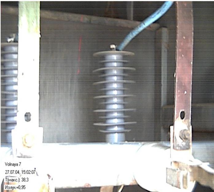
Фото 1. ОПНы типа Varisil HE15 в ячейке ТН-10 ПС 35/10 кВ Вольная Евпаторийского ВРЭС.
